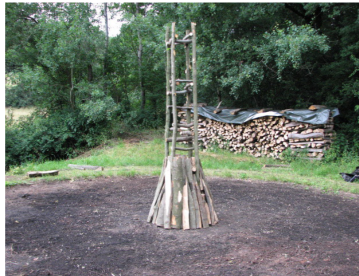
Montage de la cheminée (source : www.en.wikipedia.org avril 2020)
